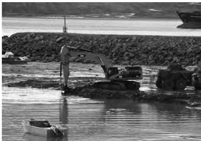
Pangnirtung, Nunavut - La construction d'un port pour petits bateaux est en cours. Photographie gracieusement offerte par la municipalité de Pangnirtung.
